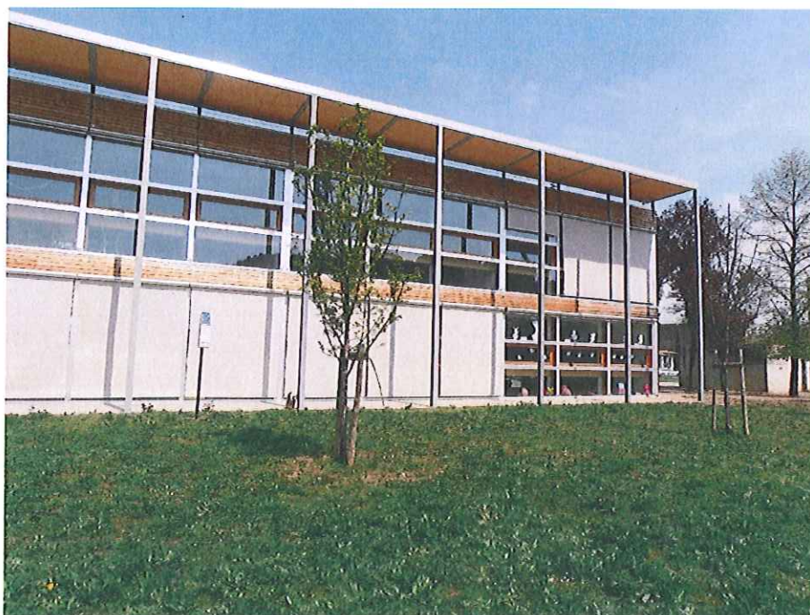
Foto 3 punto di monitoraggio corrispondente al punto di misura 5
